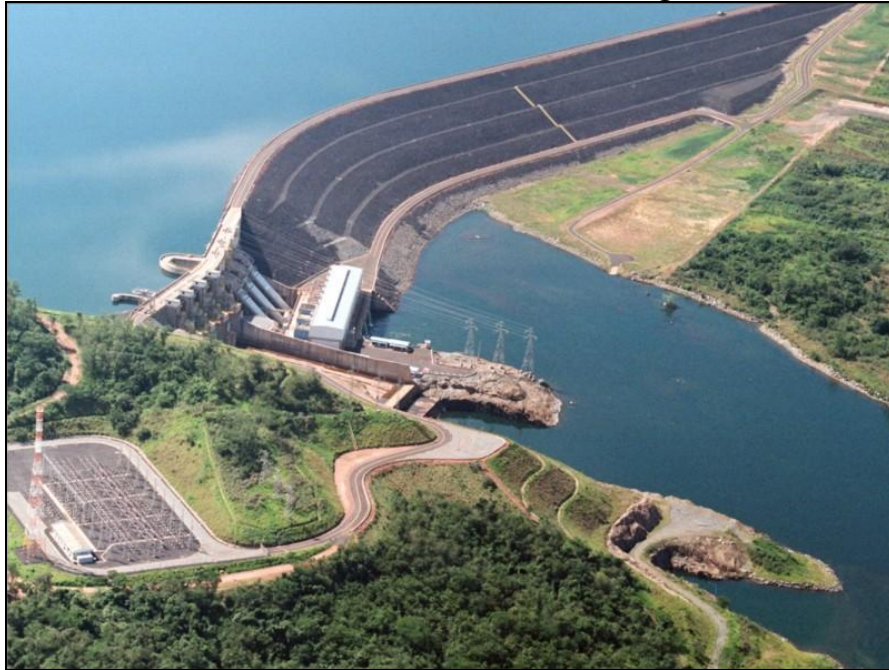
Foto 4 – Vista aérea da UHE Amador Aguiar II.
